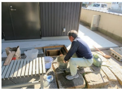
納骨堂周辺外構整備
